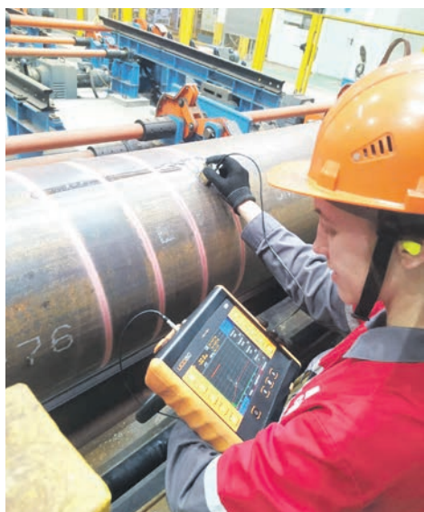
△ Вода теперь не смывает технологические отметки © АРХИВ ОМК
